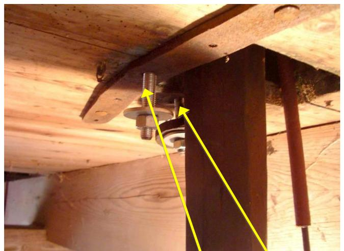
Die neu angeschweißten Gewindestangen der beiden »**Spann-Keile**«
