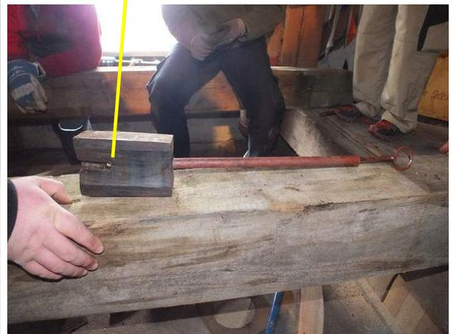
»Spann-Keile« keilförmig zulaufend !
