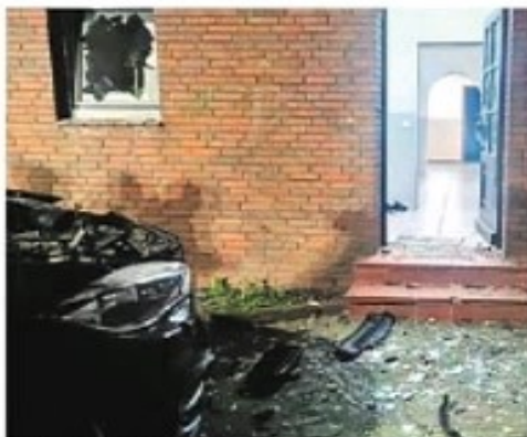
In der Ledastraße in Wittmund ist am 14. Mai 2023 ein Auto explodiert. Außer dem Fahrzeug wurde auch das Haus beschädigt. (Bild: Polizei)
